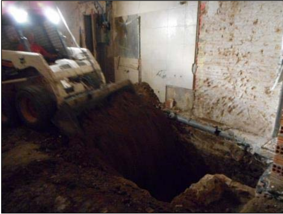
19. Màquina realitzant el rebliment del fossat/sondeig.
