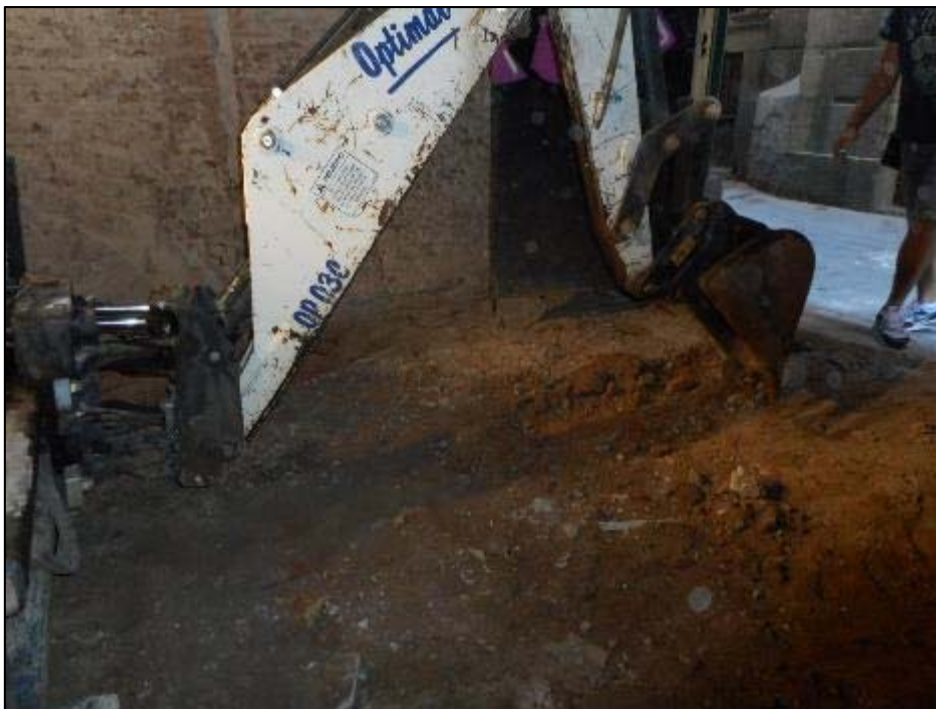
20. Inici del buidat de la claveguera central UE014.
