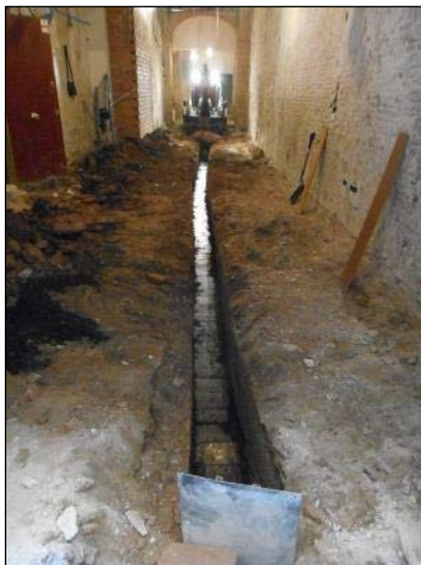
26. Vista general del buidat de la claveguera central UE014.
