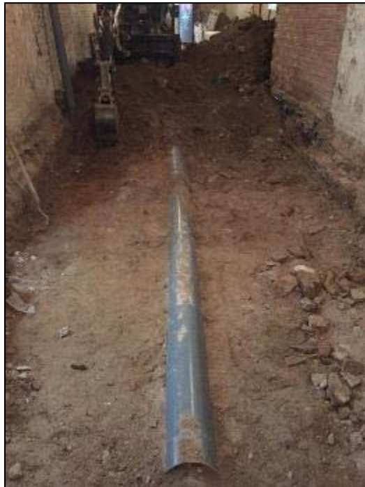
60. Rebaix general del centre del solar-planta soterrani, àmbit 1-2.
