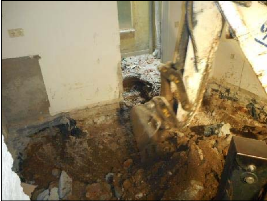
45. Inici del rebaix general de l'àmbit 4.
