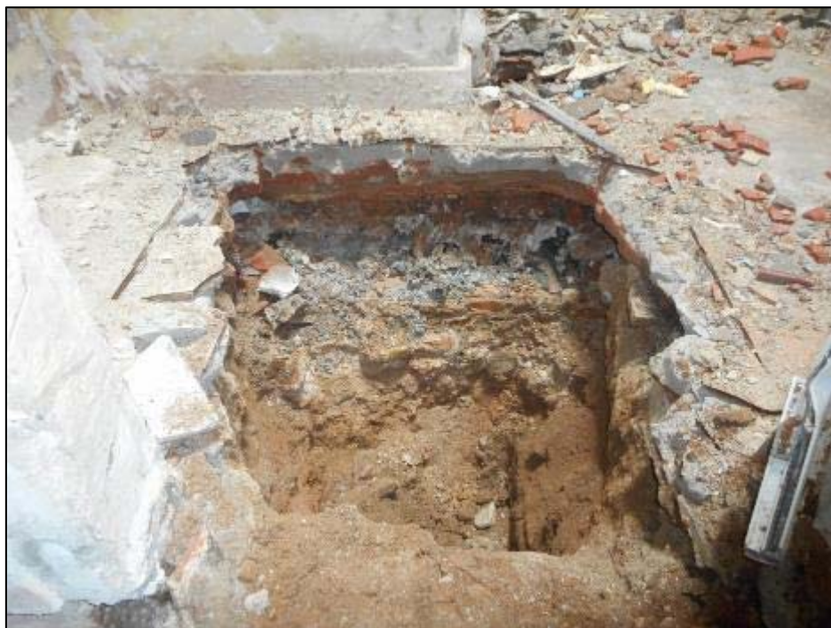
36. Realització de l'espai per a una arqueta del nou ramal de la claveguera UE014 a l'àmbit 5.
