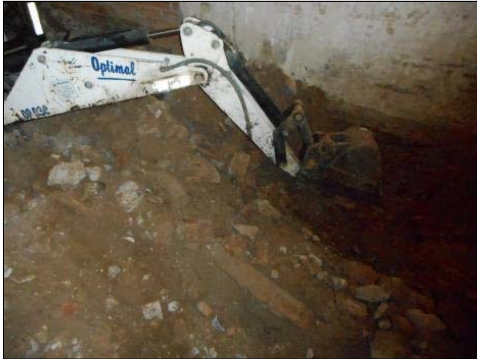
57. Rebaix general del centre del solar-planta soterrani, àmbit 1-2.
