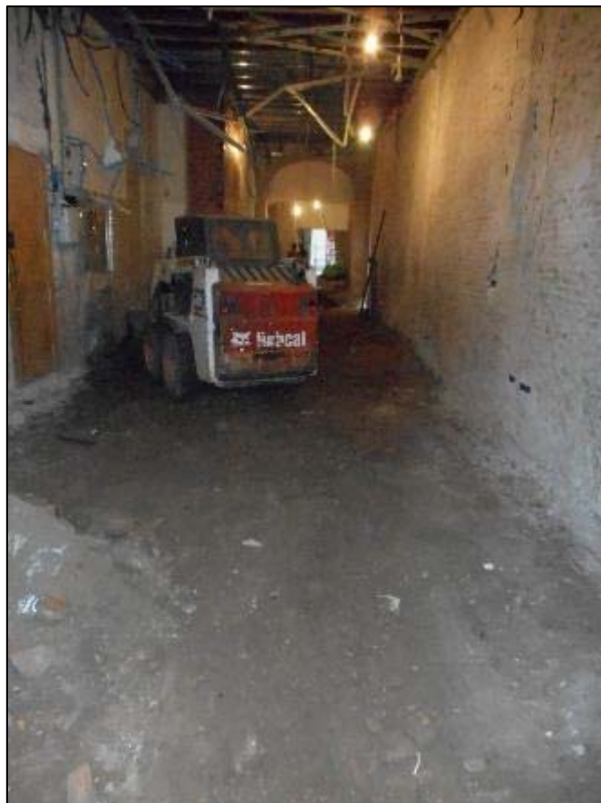
16. Màquina realitzant el rebliment del fossat/sondeig.
