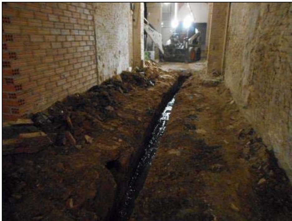
27. Vista general del buidat de la claveguera central UE014.
