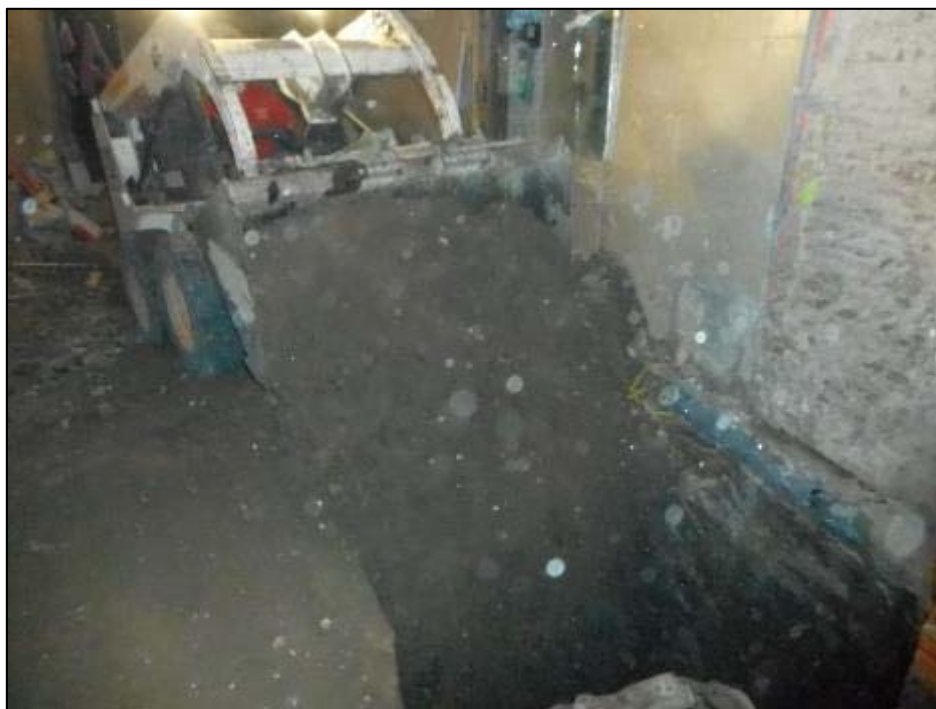
17. Màquina realitzant el rebliment del fossat/sondeig.
