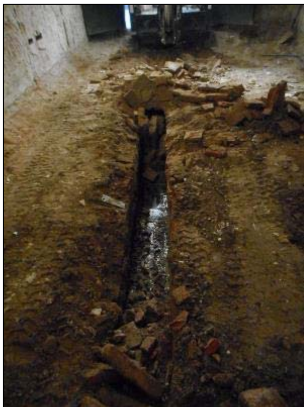
23. Buidat de la claveguera central UE014.
