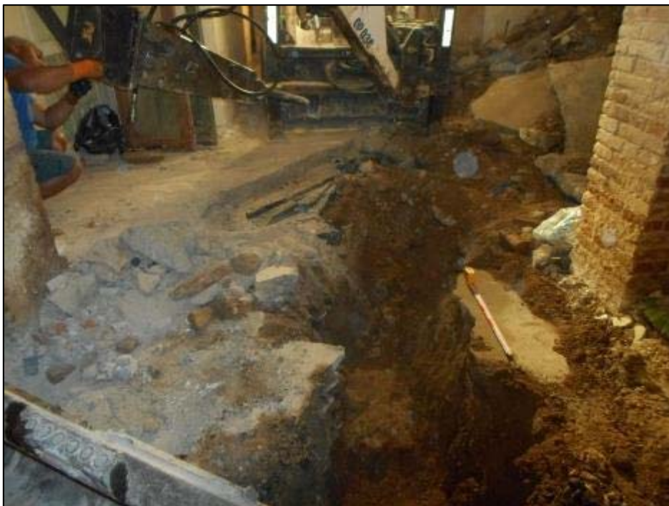
32. Treballs de realització dels nous ramals de la claveguera UE014.
