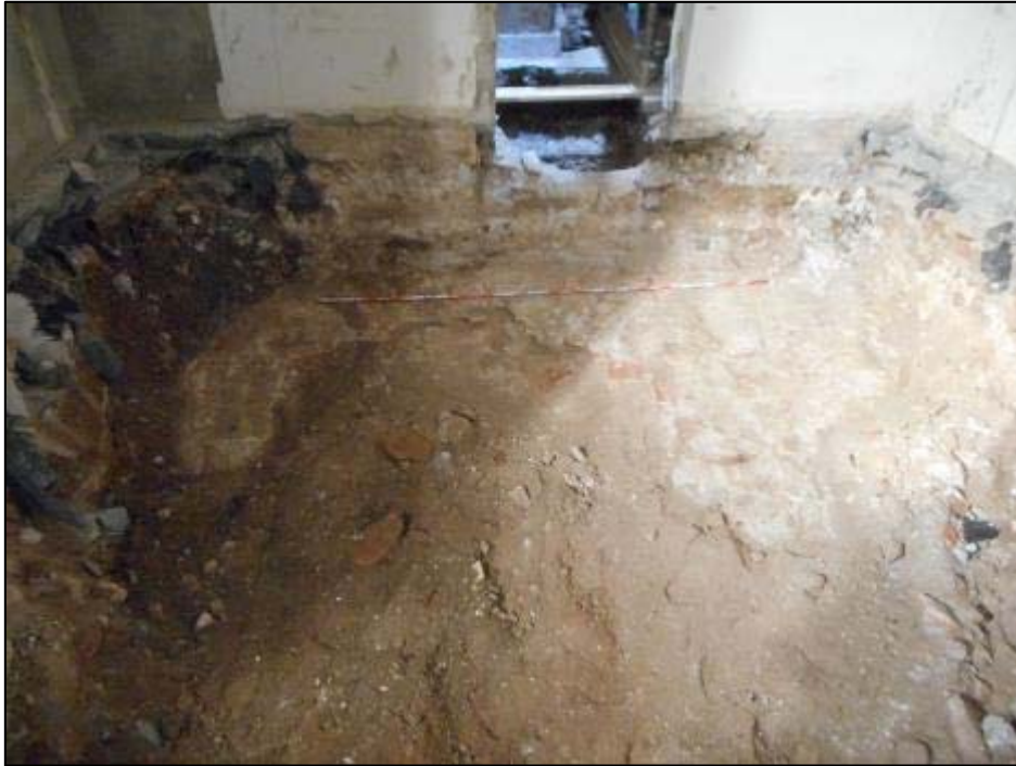
51. Detall del paviment UE019 localitzat a l'àmbit 4.
