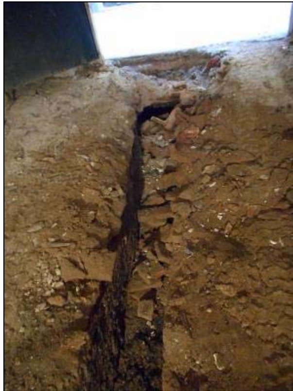
25. Buidat de la claveguera central UE014.
