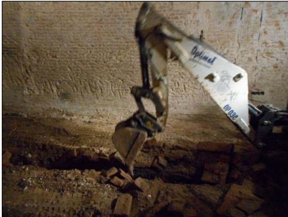
21. Buidat de la claveguera central UE014.
