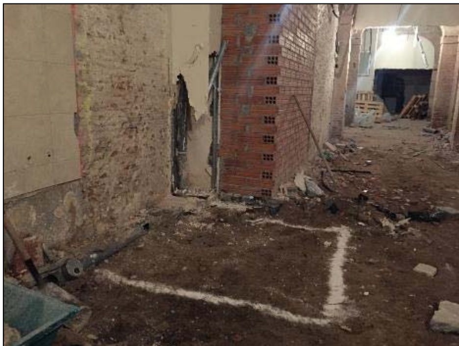
3. Situació del nou fossat/sondeig dins el solar, establert com a mesura correctora.
