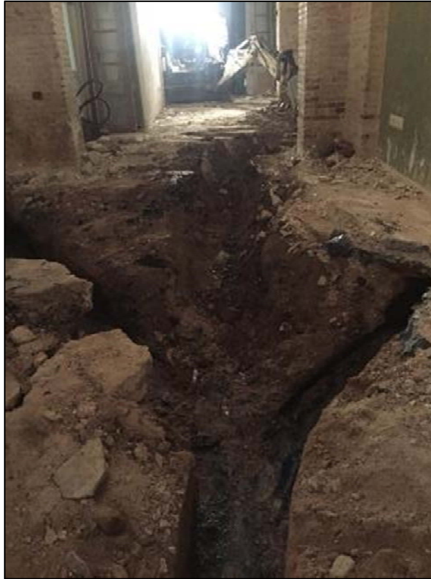
55. Rebaix general del centre del solar-planta soterrani, àmbit 1-2.
