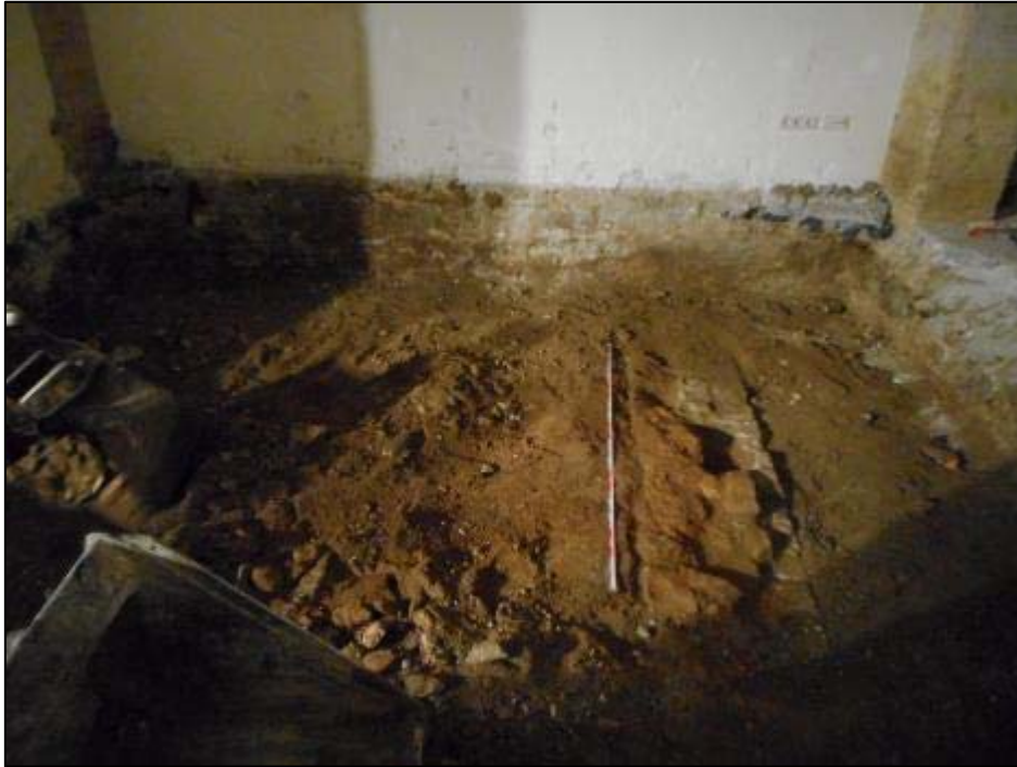
43. Situació del mur UE016-017 dins a l'àmbit 3.
