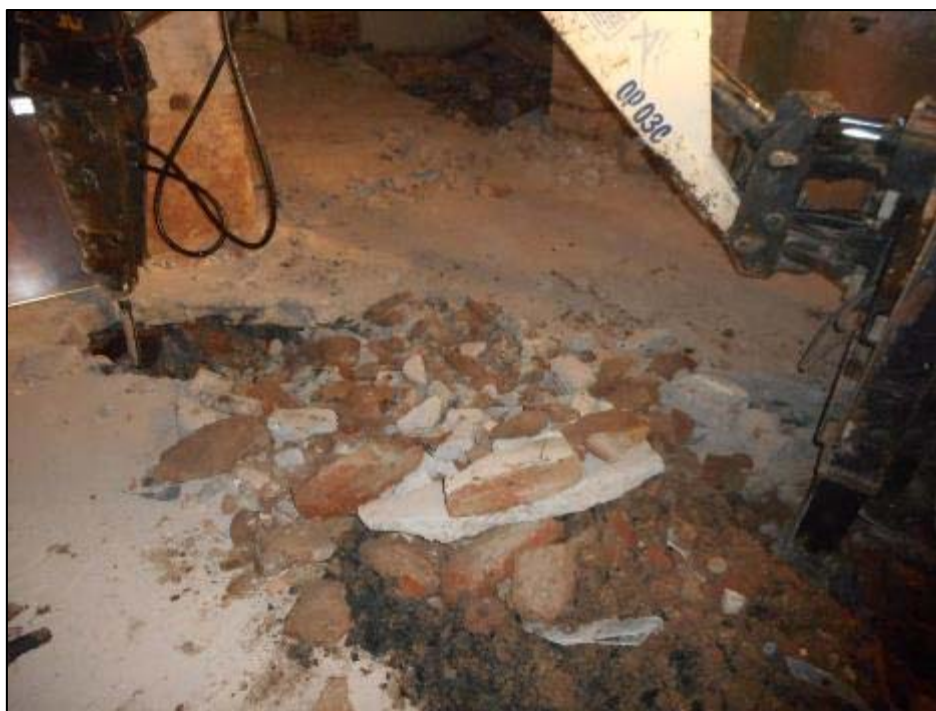
28. Desmuntatge del paviment de formigó de l'àmbit 2.
