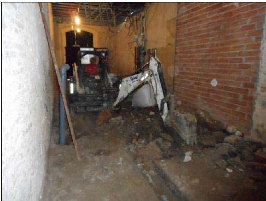
56. Rebaix general del centre del solar-planta soterrani, àmbit 1-2.
