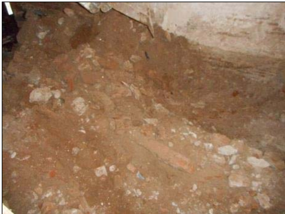
58. Rebaix general del centre del solar-planta soterrani, àmbit 1-2.
