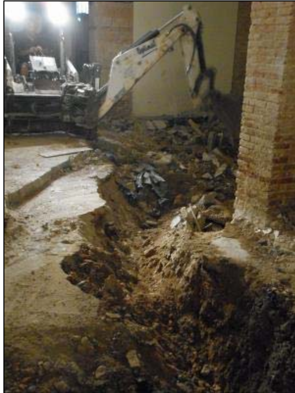
39. Rebaix de l'àmbit 3.
