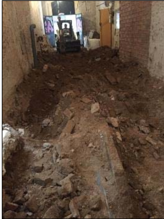
59. Rebaix general del centre del solar-planta soterrani, àmbit 1-2.
