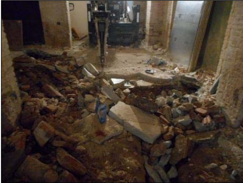
29. Desmuntatge del paviment de formigó de l'àmbit 2.
