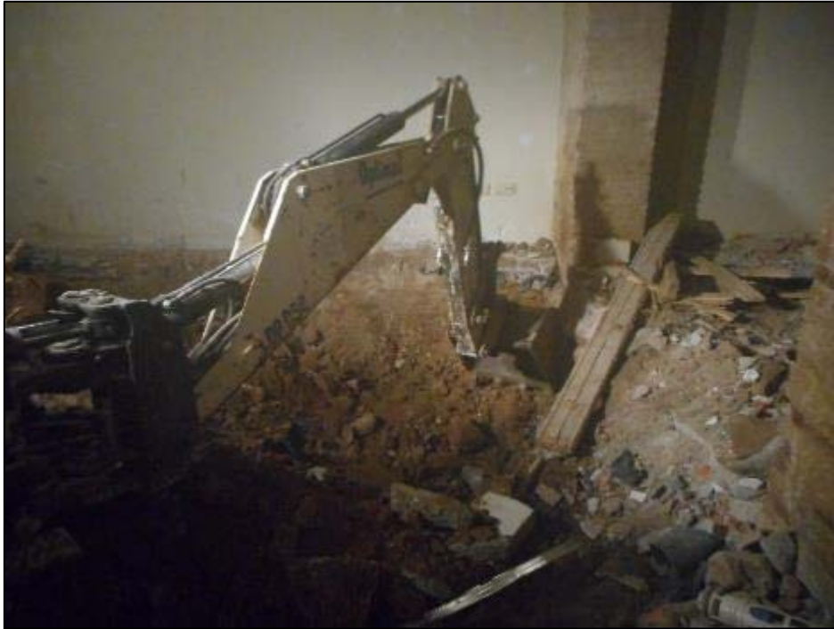
37. Rebaix de l'àmbit 3.
