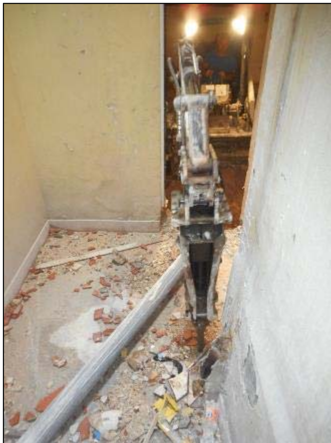
35. Realització de l'espai per a una arqueta del nou ramal de la claveguera UE014 a l'àmbit 5.
