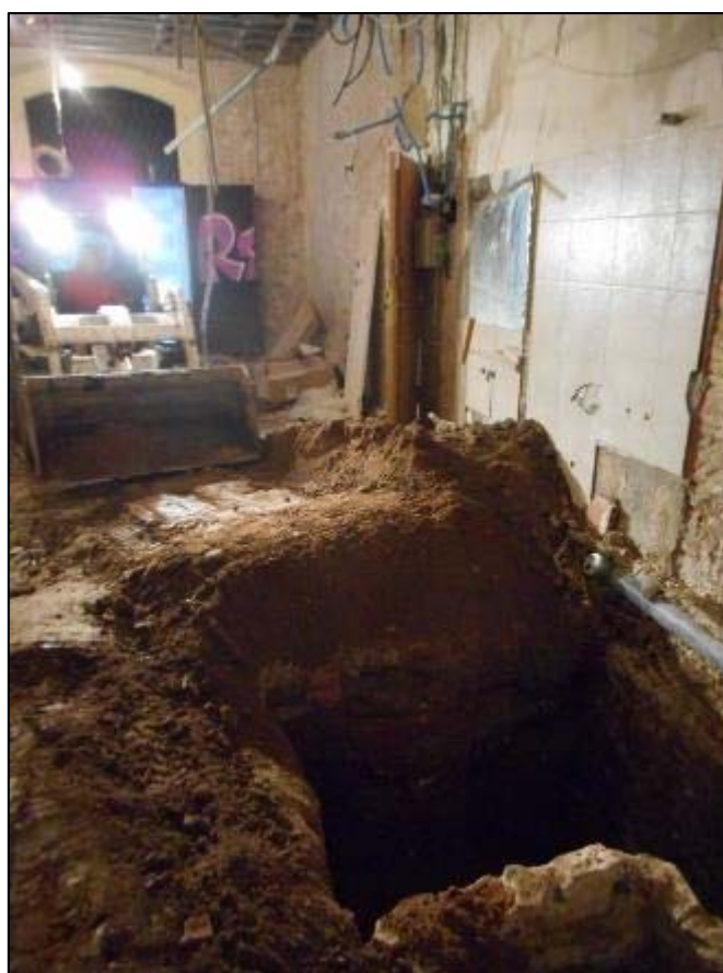
18. Màquina realitzant el rebliment del fossat/sondeig.
