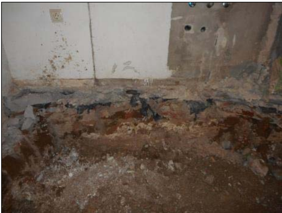
46. Rebaix de l'àmbit 4.
