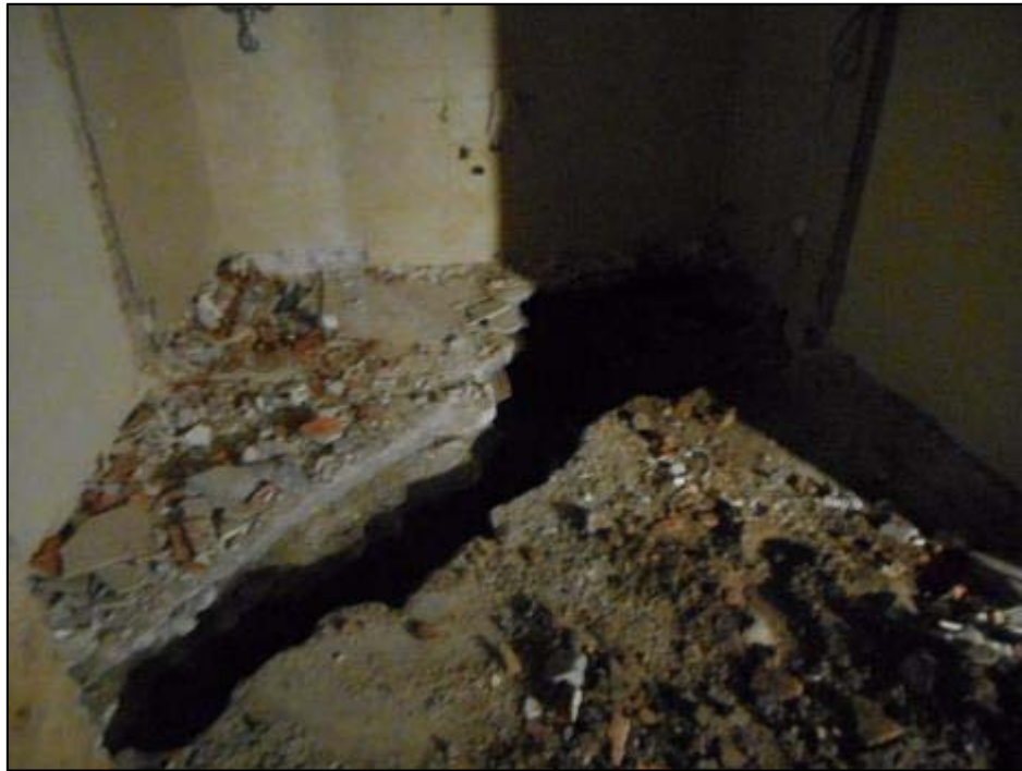
33. Nou ramal de la claveguera UE014 a l'àmbit 3.
