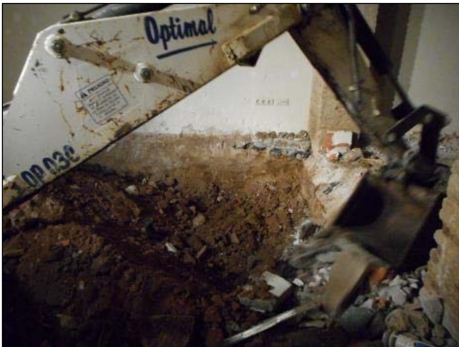
38. Rebaix de l'àmbit 3.
