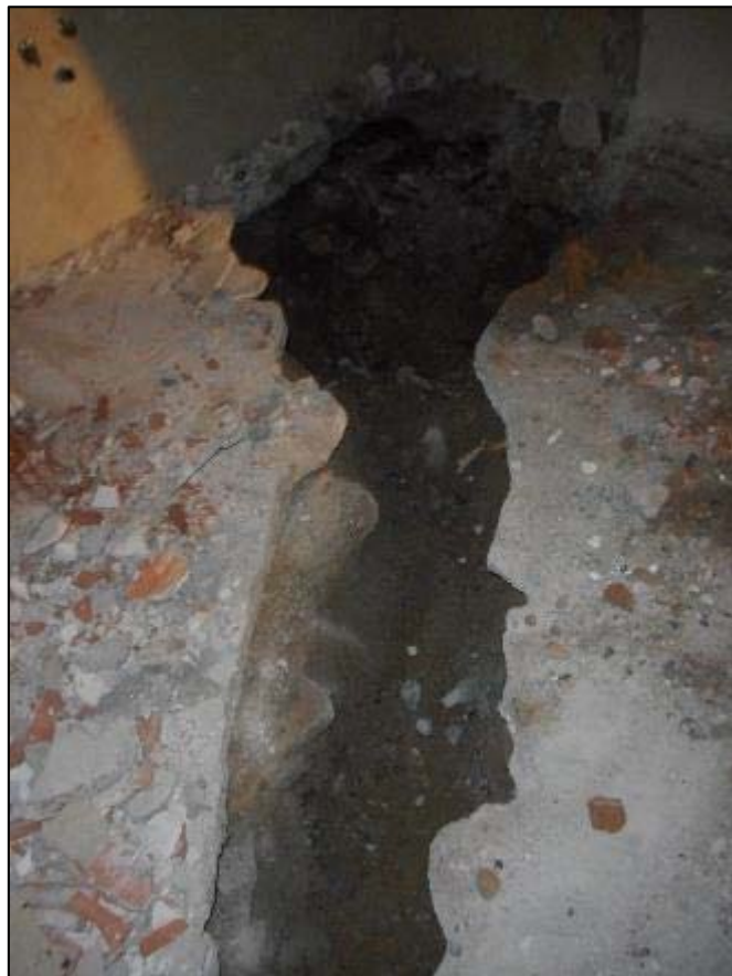
34. Nou ramal de la claveguera UE014 a l'àmbit 3.
