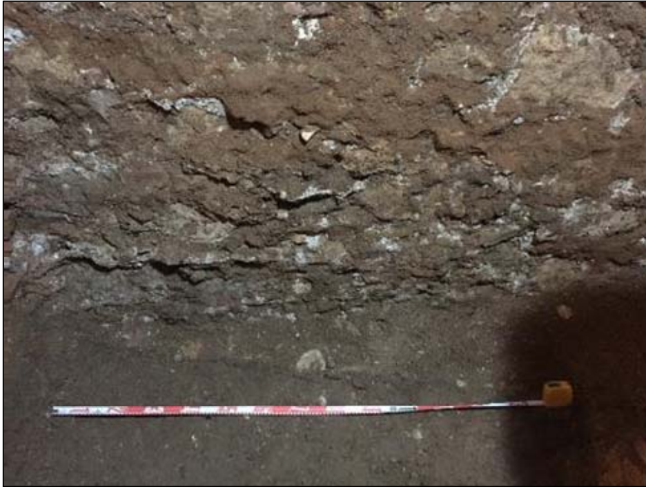
15. Detall de la rasa UE011 i fonamentació de l'edifici actual.
